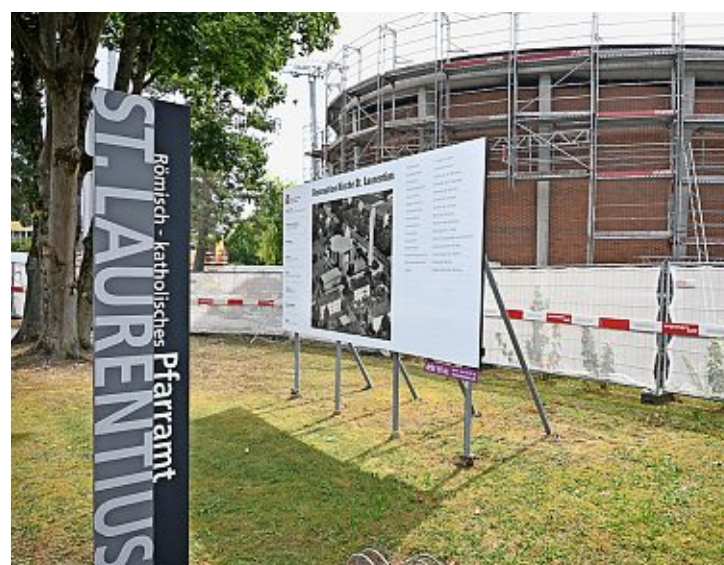
Die Kirche St. Laurentius in Wülflingen wird saniert. Foto: Madeleine Schoder
