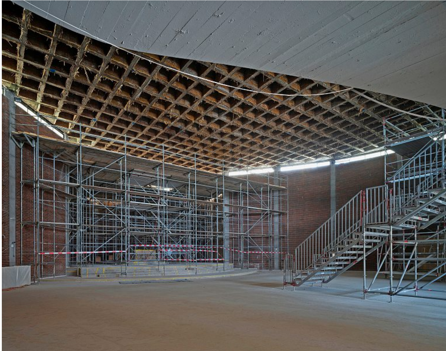
Weitgespannte Decke: Die ungefähr ein Meter hohen Rippen überkreuzen sich im rechten Winkel und überspannen mit 680 Kassetten eine Raumdimension von 30 mal 40 Metern. Fotos: Laura Egger
